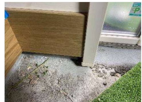
玄関ドア枠の下から、多くの漏気がありましたが、仕上げ工程で無くなりますので、問題ありません。
