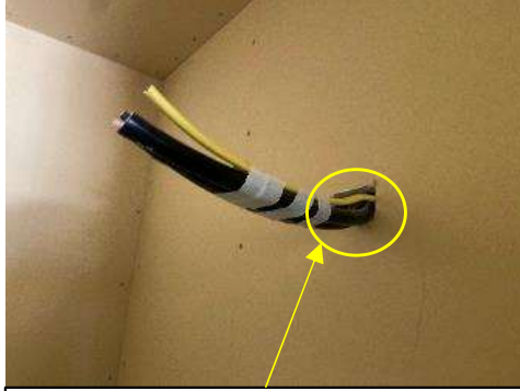
エアコン配管回りの隙間を是正することをお勧めします
